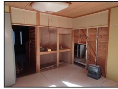
軽井沢町鳥井原のN様邸改修工事から。古い別荘を購入して改修する計画のN様邸。間取り変更を伴う工事で既存筋交いを撤去してMクロスによる耐力壁を新たに設置したり、柱を可能な範囲で移動したり、和室を大壁の洋室に改造したりと、構造を含む改修工事になりました。キッチンでは移設する耐力壁が確保でき
