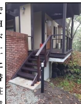
軽井沢町ではY様別荘とH様別荘でウッドデッキの改修工事を並行して施工しました。どちらも腐ってしまった階段の段板を交換。併せて塗り替え工事もしました。Y様別荘は屋根の清掃と樹木の伐採、H様別荘ではセンサーライトによる外灯の設置工事もしました。寒くなる前に冬に向けた準備が出来たので、お施主様にはご安心いただけるものと考えています。
