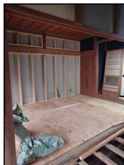
佐久市春日N様邸古民家改修工事は引き続き床下地の補強と張り替え、構造壁の増設
