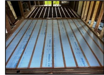
次は佐久市春日N様邸古民家改修工事。奥様の機織りの機械を並べるため、座敷の二間は今月中に床を仕上げたいとのご要望。床下の大引補強に始まり、痛んだ根太の交換、不陸を取りながら逆方向に新たな根太を入れて、防蟻処理をした上で断熱材も施工。下張りの構造用合板張りまで施工済み。ナラの無垢フローア張りへと進みます。塗装はお施主様が柿渋を塗る予定です。
