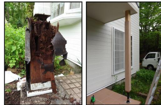
て目地を減らして施工しました。問題は柱下部。タイルを剥いたら木下地は腐れとクロアリによる
